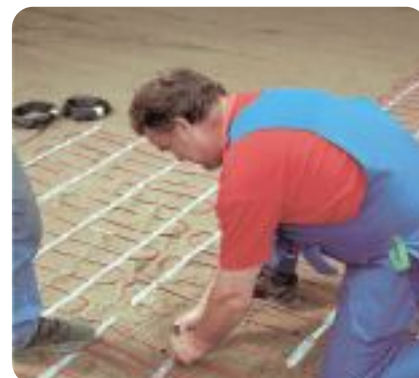
Przykładowa instalacja kabla grzejnego pod kostką brukową
